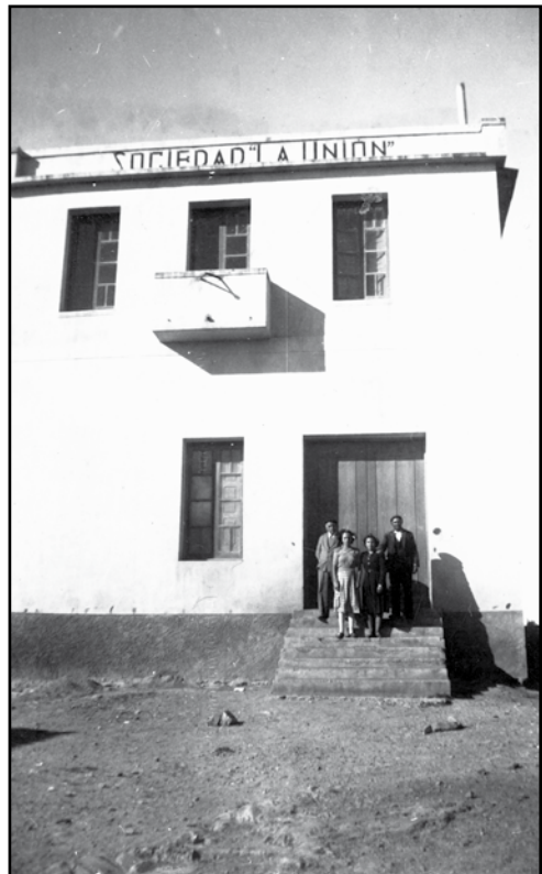
Edificio con la antigua escalera (1950)
