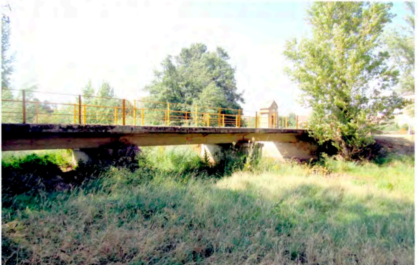
1970 - PUENTE DE LAS ÁNIMAS RECONSTRUIDO
